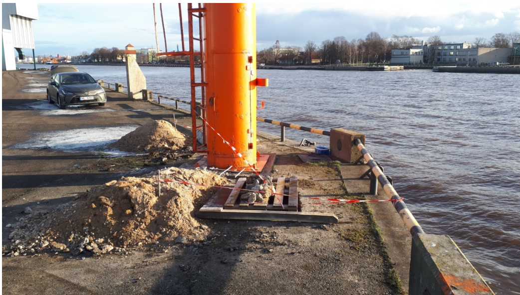
1.att. Skats uz dzelzsbetona virsbūvi. Redzamas piestātnes atseguma vietas.
